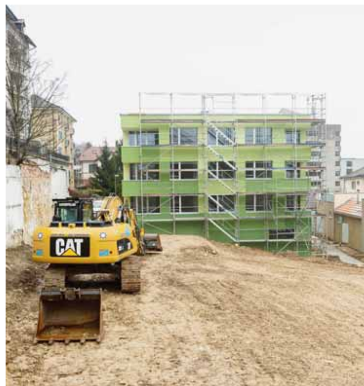
Le nouveau bâtiment de la coopérative du Vieux-Châtel, est sorti de terre. Les locataires pourront emménager en avril. LUCAS VUITEL
